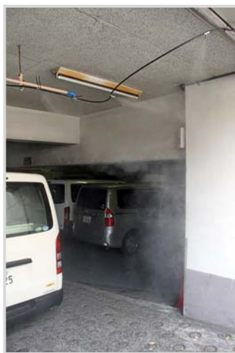
▲地下駐車場出入りに
